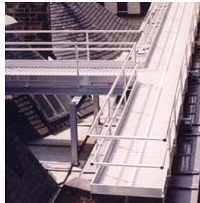
Ayuntamiento de Manchester, pasarela sobre una cubierta frágil.
