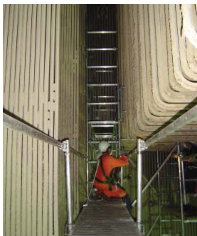
En haut, à gauche : Plate-forme d'accès au surchauffeur. Fournit un accès pour les opérateurs entre les plates-formes du surchauffeur
