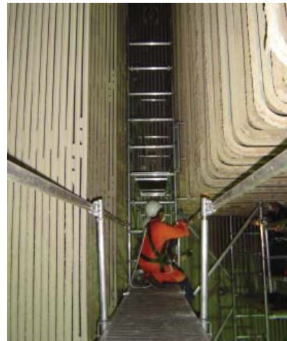
Вверху с лева: Платформа для доступа к пароперегревателю. Обеспечивает доступ для операторов между платформами пароперегревателя
