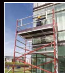
Věž s nátěrem
