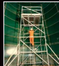
Vyjímatelný systém do kotlů Snap-Out
