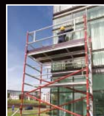
Malowane rusztowanie wieżowe
